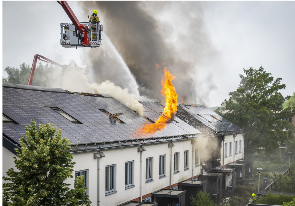
De zware brand in Arnhem kon maar heel moeilijk geblust worden omdat het hele dak vol zonnepanelen lag. FOTO ANP
